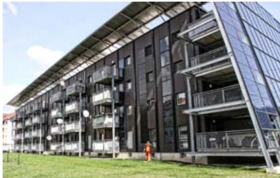
Das Gebäude wurde Bild: ENW generalsaniert, fast ohne Stemmarbeiten, denn die gesamte neue hochgedämmte Fassade wurde samt der darin befindlichen Heizungs- und Warmwasserinstallation quasi vor die bestehende Fassade gestellt, die Einzelelemente wurden vorgefertigt angeliefert. Komfortlüftung ist in diesem Gebäude eine Selbstverständlichkeit, man hat sogar
